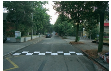
Vertikalversatz
